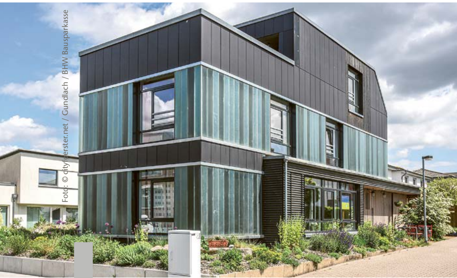
Dieses Haus in Hannover besteht komplett aus recycelten Materialien.
